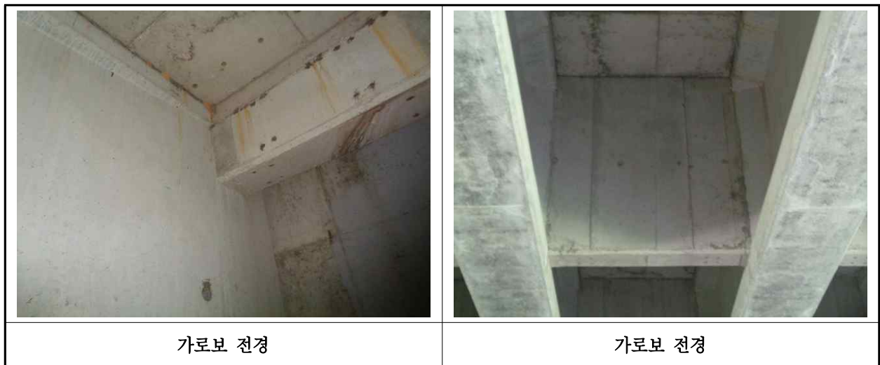
【사진 3.3.6】 가로보 전경
