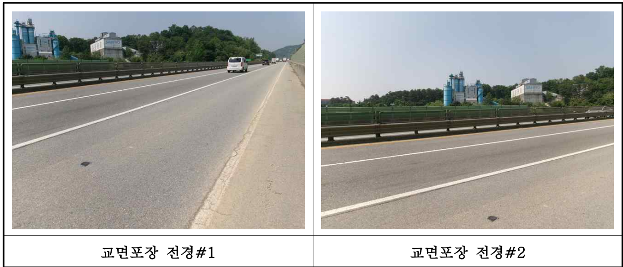
【사진 3.3.21】 교면포장 전경
