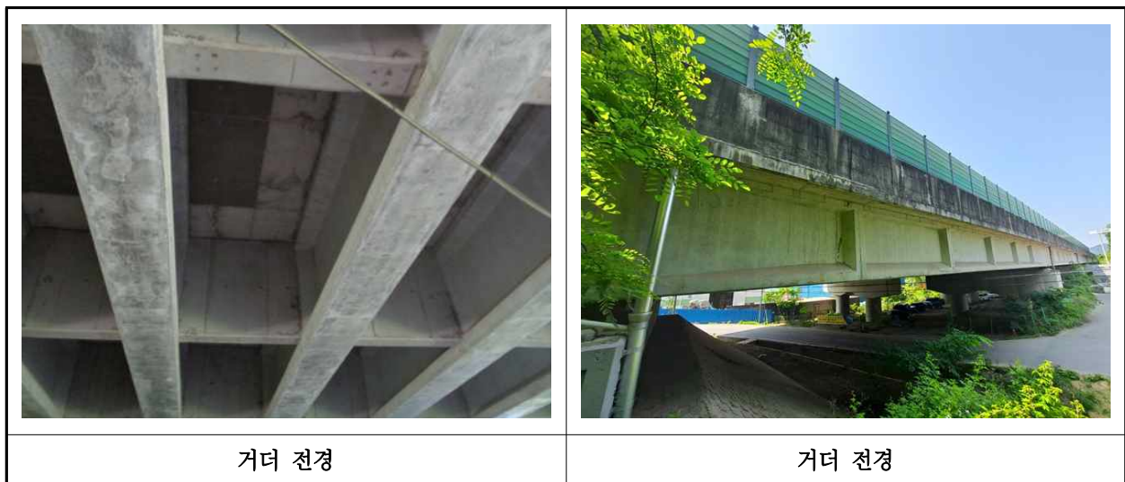
【사진 3.3.4】 거더 전경
