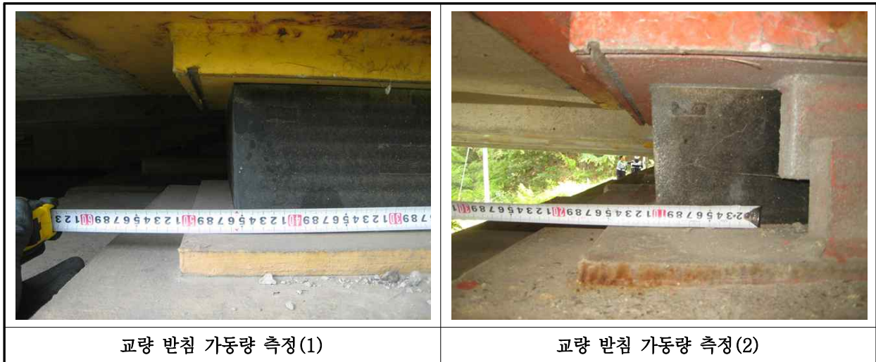
【사진 3.3.17】 교량받침 이동량 측정
