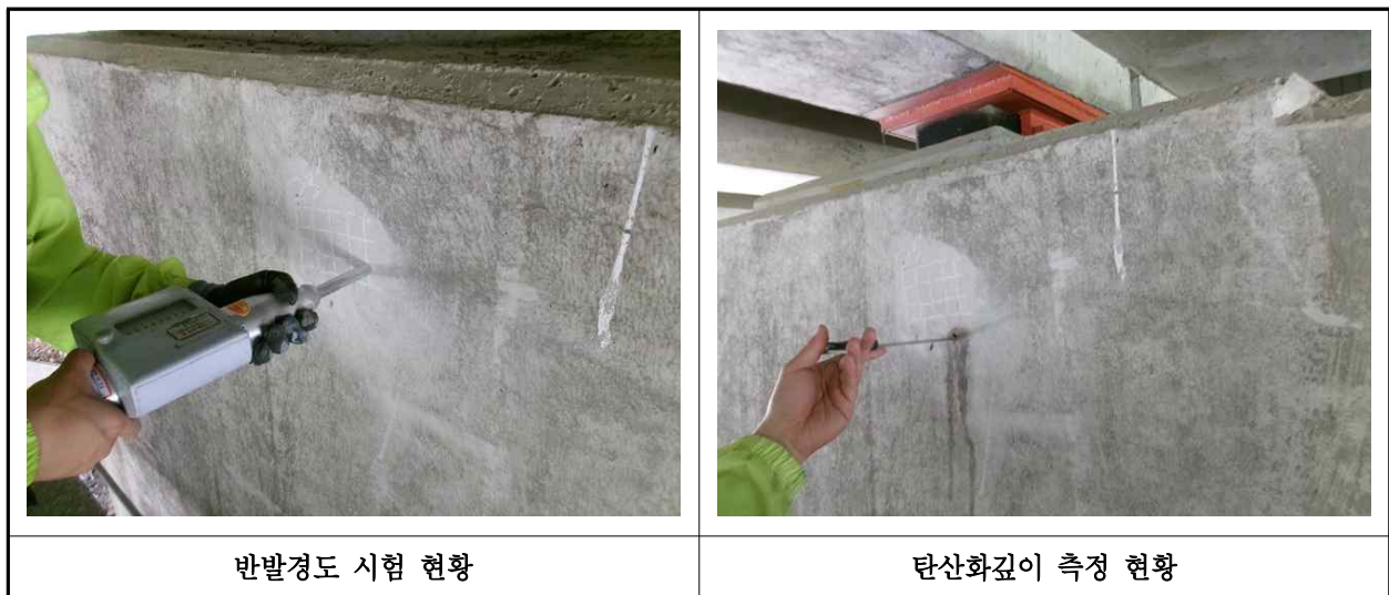
【사진 3.4.1】 콘크리트 내구성조사 현황
