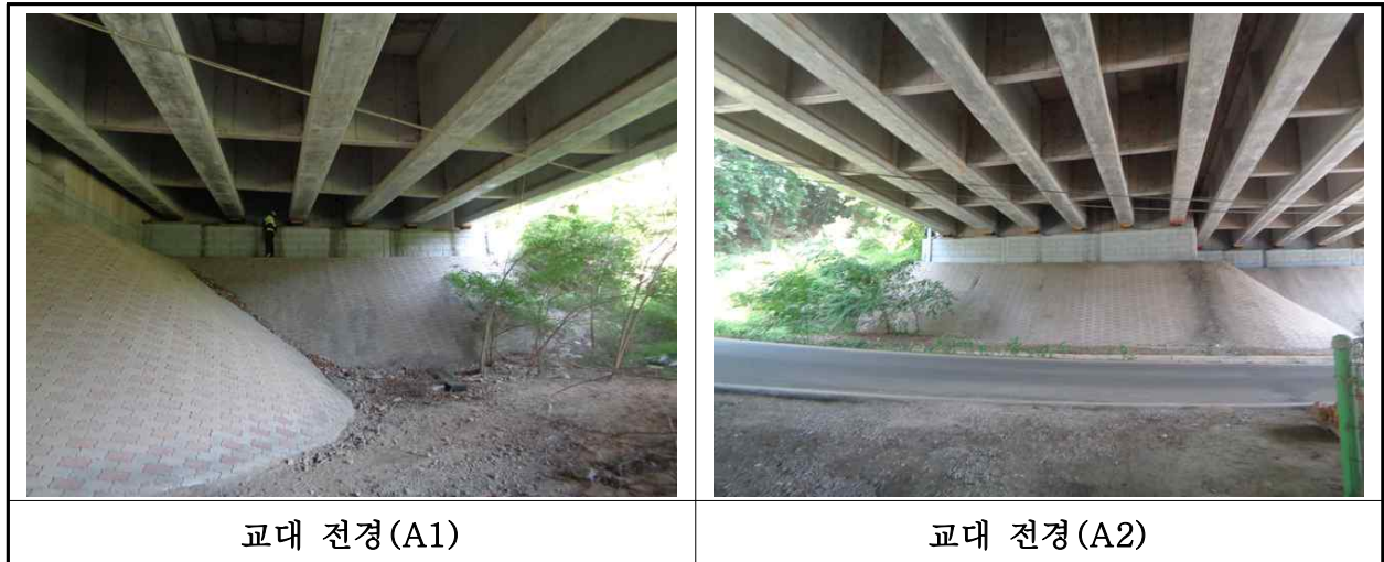
【사진 3.3.8】 교대 전경
