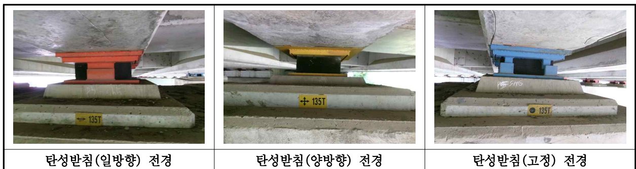
【사진 3.3.14】 교량받침 전경
