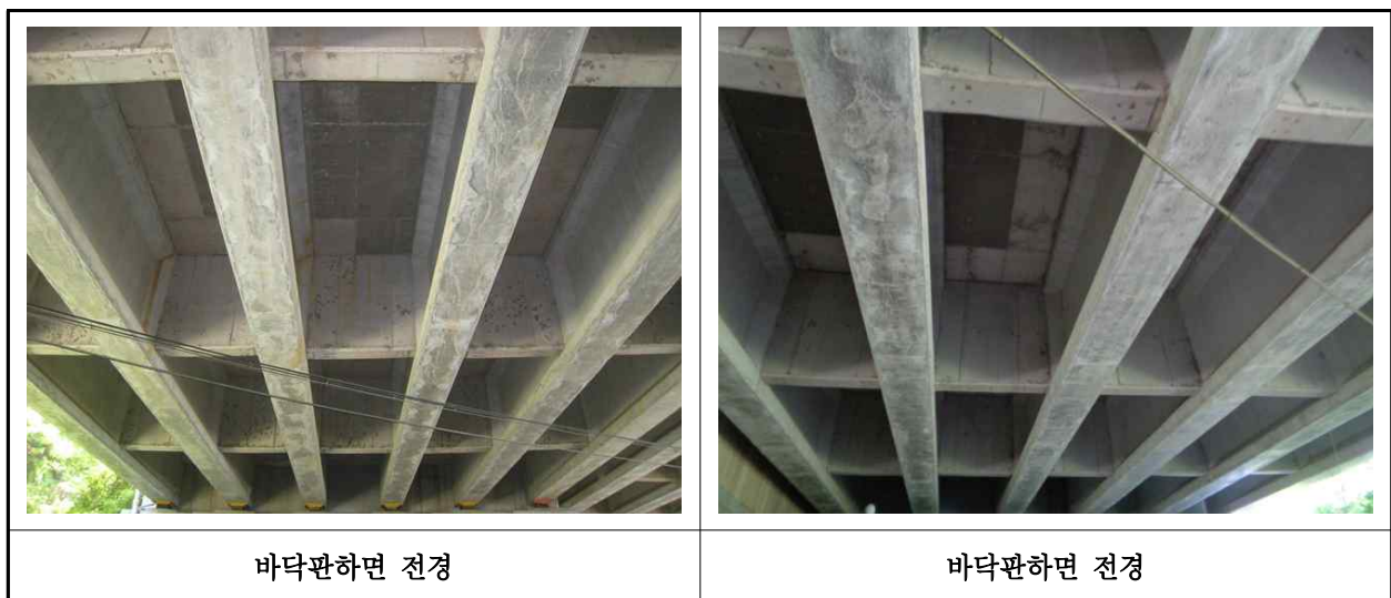
【사진 3.3.2】 바닥판하면 전경
