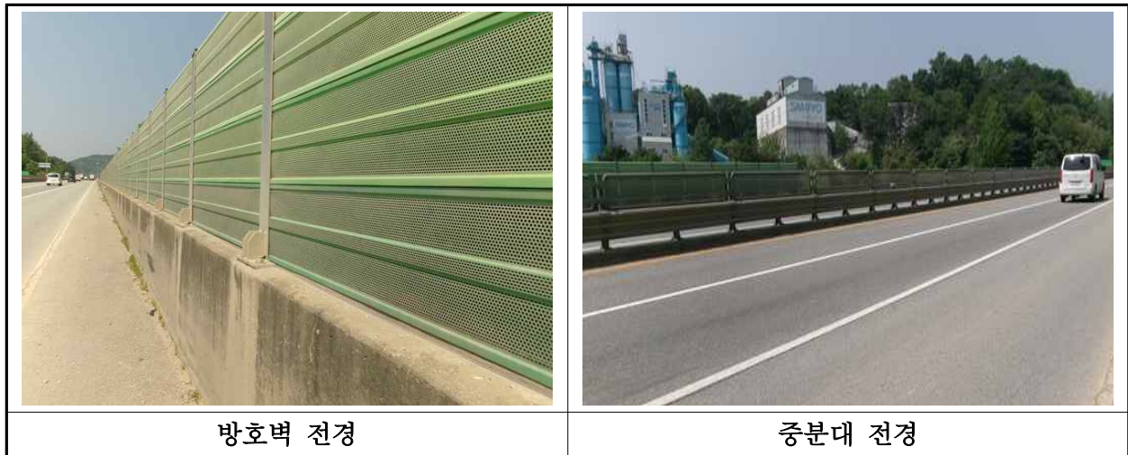
【사진 3.3.25】 방호벽 및 중앙분리대 전경
